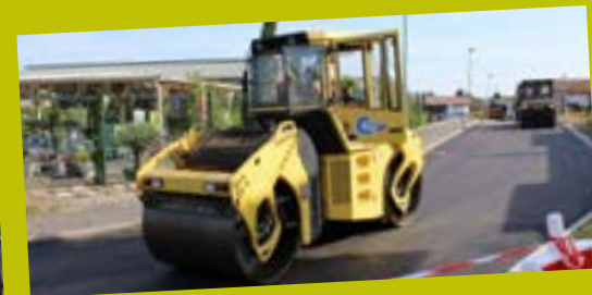
1ER JUILLET Lancement des travaux de réfection des voiries des ZAE
