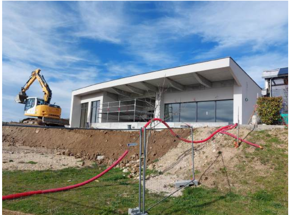
Chantier de l'espace détente de l'Ozen
